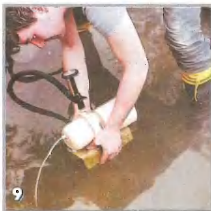
Чтобы запустить в действие погружной насос, нужно проложить электрокабель, а затем просто опустить агрегат в воду. Высоту струи фонтана, оборудованного таким насосом, можно регулировать
