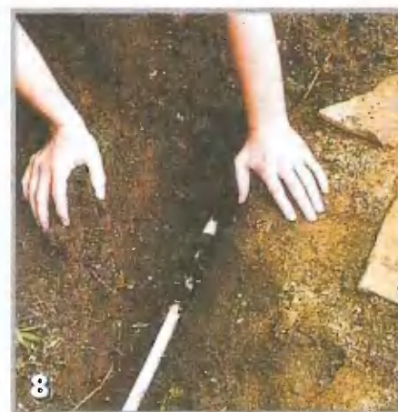
8 Электрокабель и шланги прокладывают под землей
