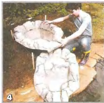
4 Опробование чаш. На этом этапе важно определить, правильно ли стекает вода из одной чаши в другую
