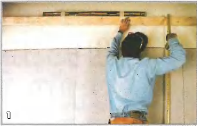
1 Замер параметров лестничного проема. Чтобы определить высоту лестницы, с помощью ровной доски с прикрепленным сверху уровнем нужно отметить линию чистого пола второго этажа в проеме
