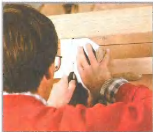
Перехлест шпона в месте пересечения каркаса подрезают по линейке и излишки удаляют, а затем эти стыки прогревают утюгом
