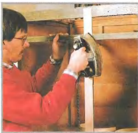
Фанеровку с нанесенным на нее термоклеем приглаживают к внешним деталям шкафа горячим утюгом
