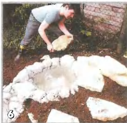
6 Камни укрепляют края чаш и предохраняют фильтр насоса от засорения
