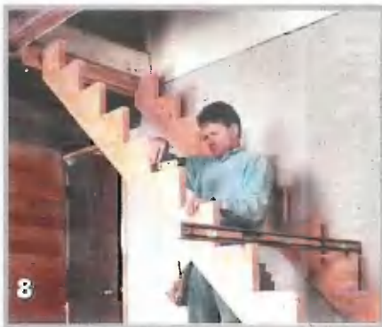
Сначала устанавливают и регулируют тетивы по отдельности. Затем уровнем проверяют их положение относительно друг друга
