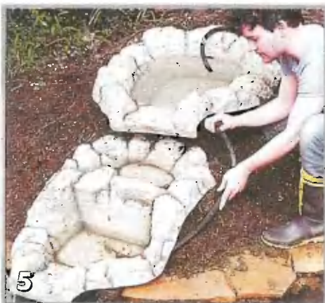
5 Магнетающий шланг лучше всего уложить непосредственно по краю каскада и замаскировать растениями
