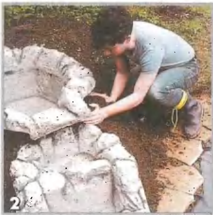
2 Чаша яруса водопада устанавливают на подходящем берегу водоема. Вынутый песок используют для подсыпки основания
