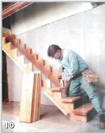
Проступи крепят на шурупах. Использование шурупов — лучший способ избежать скрипа. Отверстия для них просверливают заранее
